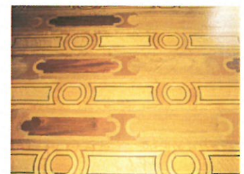
Salle de Garde Parquet floor
