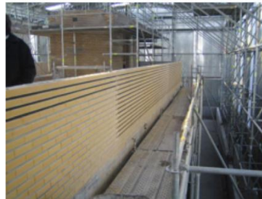
La Villa Cavois, Architecte original: Robert Mallet-Stevens. Architecte de Restoration: Michel Goutal, ACMH, Inspecteur General, Didier Repellin, ACMH.
