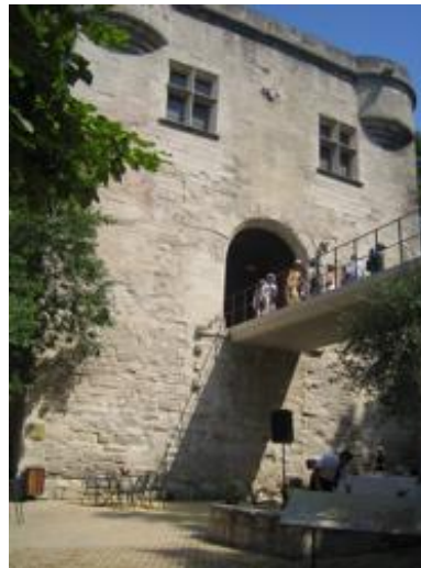
Pont Saint Benezet, Avignon. Architecte-en-Chef, M. Didier Repellin
